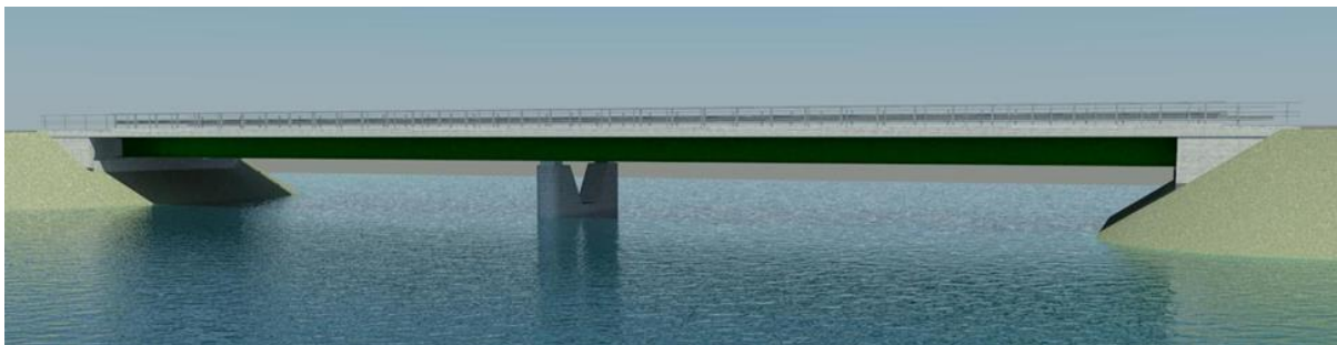
Joonis 16. Noarootsi sild 70 m (Variant 1 -terastaladega komposiitristlõikega sild)
